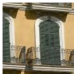
Muros y fachadas
